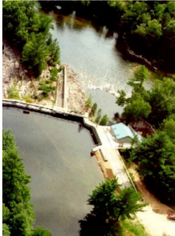
Figure 21 : Petite centrale hydroélectrique de 700 kW dans une zone rurale (Ontario) [Ah-YOU]
