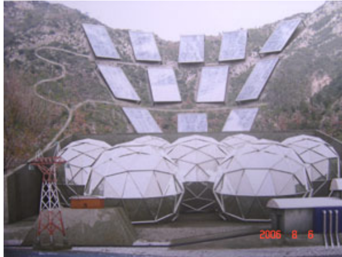
Figure 57 : Sphères en matériaux composites pour stocker l'air comprimé dans le cadre du projet d'une centrale solaire associée à CAES sur la Côte d'Azur en France [ECO]
