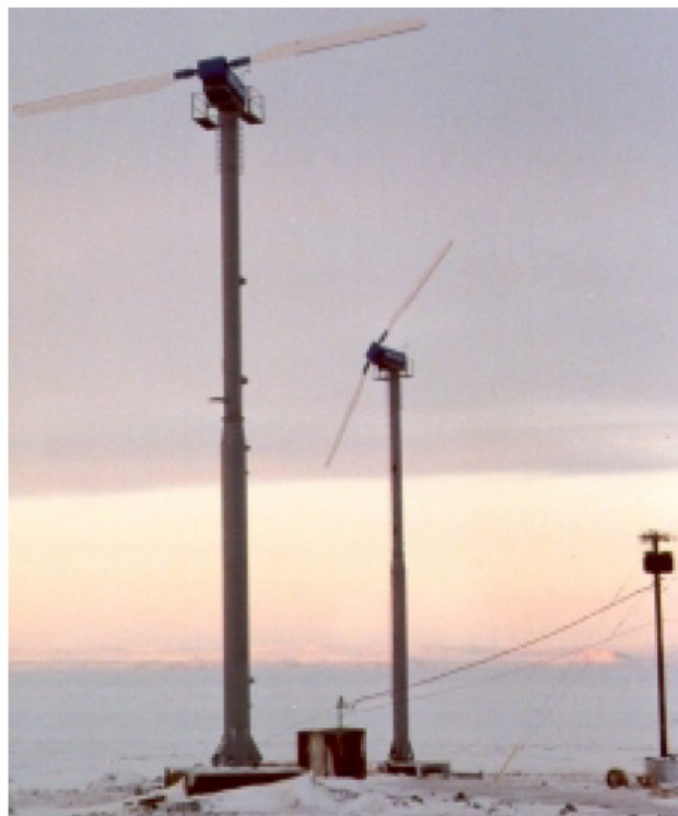
Figure 15 : Deux éoliennes de 80 kW branchées à un réseau diesel isolé à Kugluktuk (territoires du Nord-Ouest)
