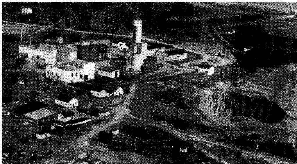
B. Vue aérienne vers l'est de la mine East Sullivan en 1964, quelques années avant sa fermeture. L'exploitation des piliers de surface apparaît en phase initiale avec une seule petite fosse. (Photo: Société d'histoire de Val d'Or, Fonds Lorenzo Gauthier).
