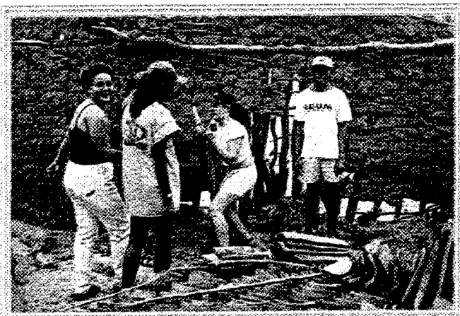
Foto: Montagem da casa de farinha rústica no bloco temático processo produtivo (ADAC - Abr/97)
