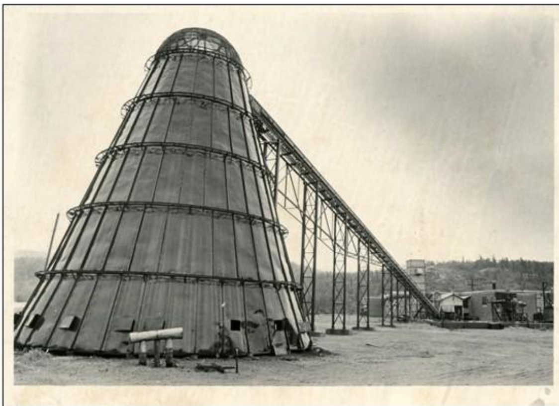
Figure 52: Scierie Jos-Houde, Petit-Saguenay, s.d., [Silo pour l'entreposage des résidus de bois].
