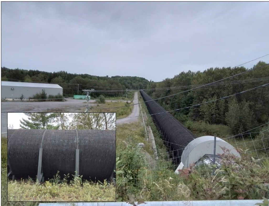
Figure 87: Section de la conduite d'amenée en douelles de bois de la Centrale Murdock-Wilson (1957).
