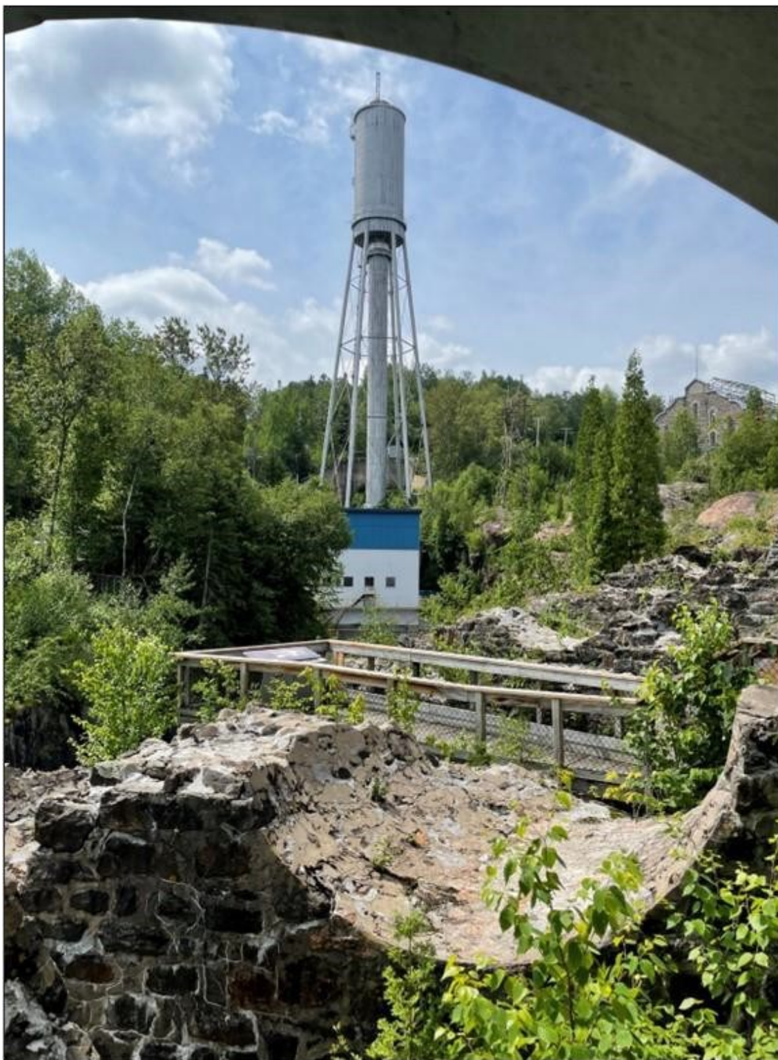
Figure 44: Centrale et cheminée d'équilibre d'Elkem Métal, sur le site de la Pulperie de Chicoutimi.
