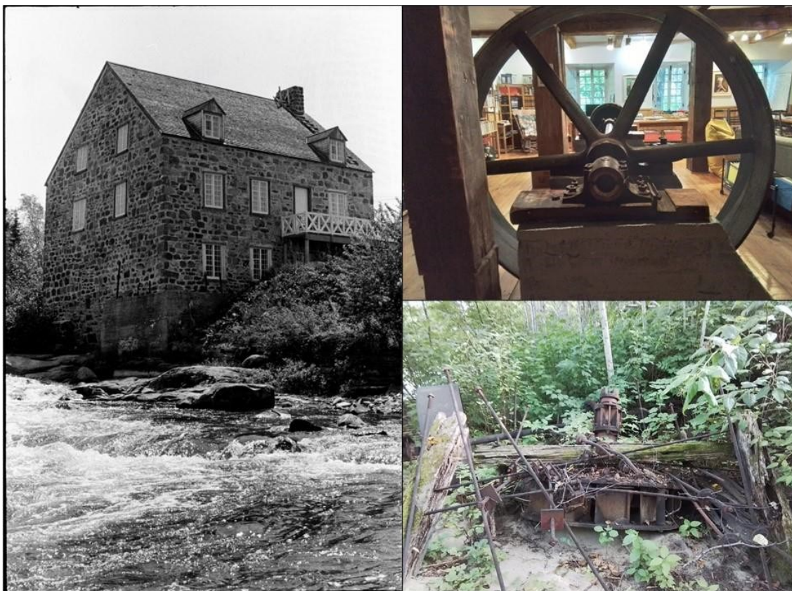
Figure 70: Moulin du Père Honorat/Moulin Gauthier, Laterrière, en 1976 / Roue de transmission entraînée par la turbine du moulin et diverses pièces d'équipement de la scierie, dont une ancienne roue de type Poncelet.
