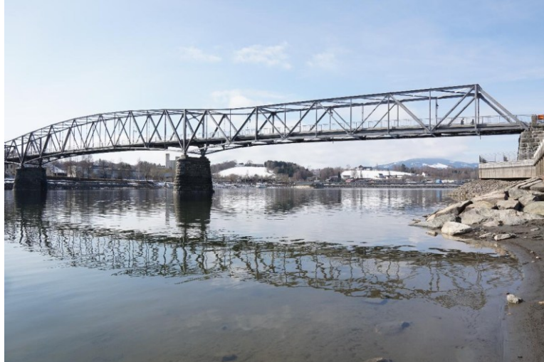
Figure 4 : Passerelle en treillis (Structurea,2026)
