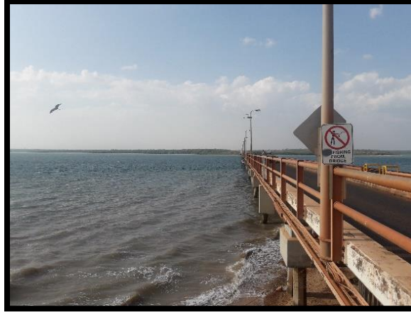
Figure 2.15 : Pont en direction du port
