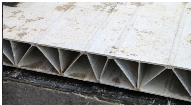
Figure 1.5 Tablier du pont de St-Ambroise (photo gracieuseté M. Fafard)
