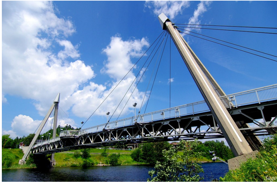
Figure 2.1 Passerelle de la rivière aux sables. [73]
