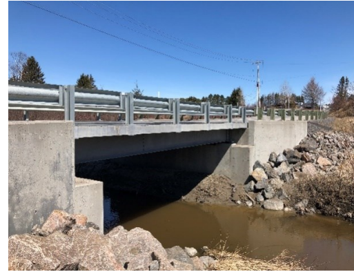
Figure 5-3 : Photographie du pont de St-Ambroise. © Côte Cloutier, 2020
