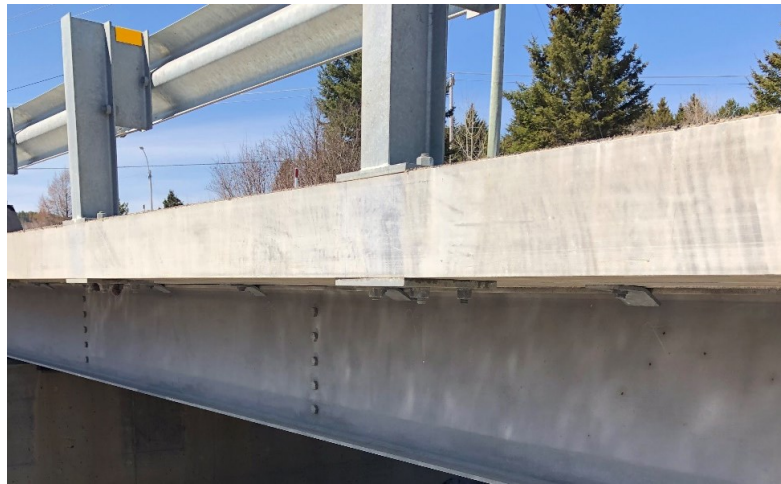
Figure 6-6 : Attache du dispositif de retenue, vue du côté du pont © Côme Cloutier, 2020
