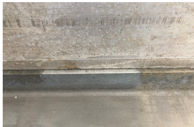
Figure 6-3 : FSW à proximité de l'aile d'une poutre principale © Côme Cloutier, 2020
