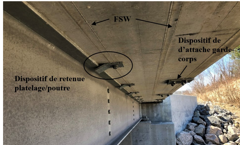
Figure 6-4 : Vue du dessous en porte-à-faux du platelage avec dispositif d'attache à l'intérieur d'une soudure.
