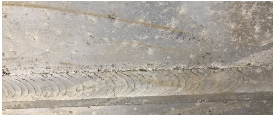
Figure 3-4 : Strie et bavure sur un joint fait par friction malaxage en dessous du pont de St-Ambroise © Côme Cloutier, 2024
