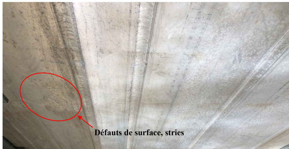
Figure 6-2 : Dessous du platelage entre les poutres principales © Côme Cloutier, 2020
