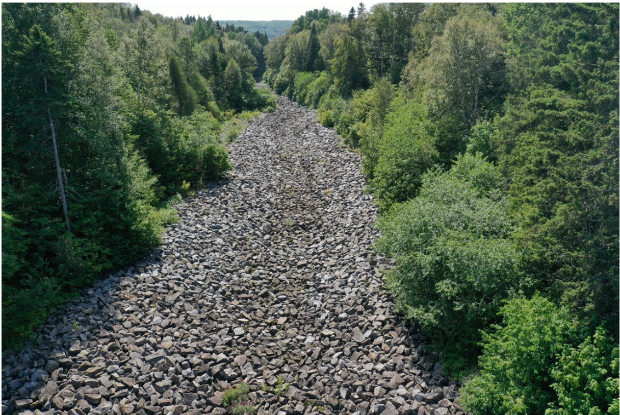
Figure 26. Exemples de revêtements constitués de matériaux granulaires grossiers (© Firme Rivières)
