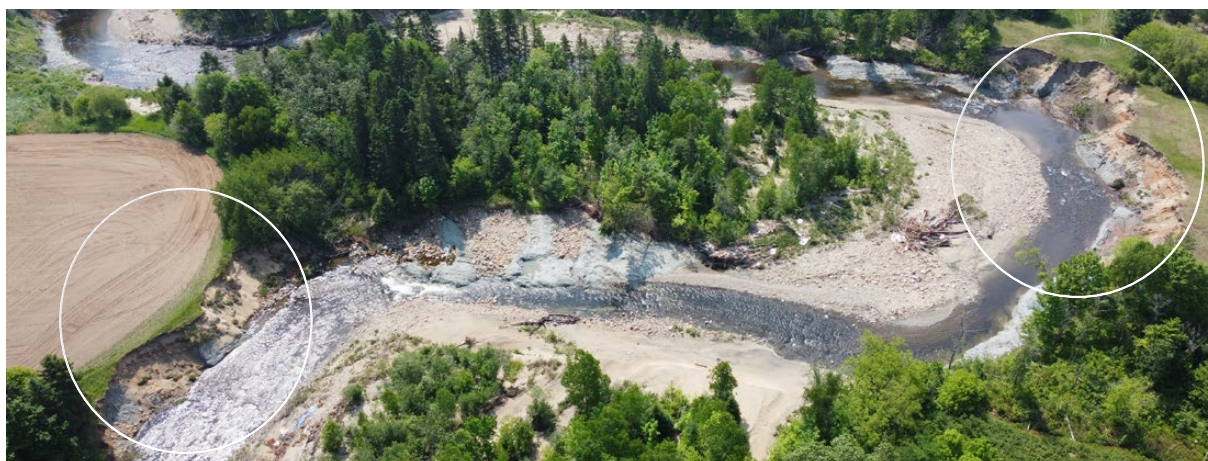
Figure 37. Exemple d'érosion latérale tel qu'attendu, i.e. au niveau des rives concaves d'un cours d'eau à méandres actifs (© Firme Rivières)
