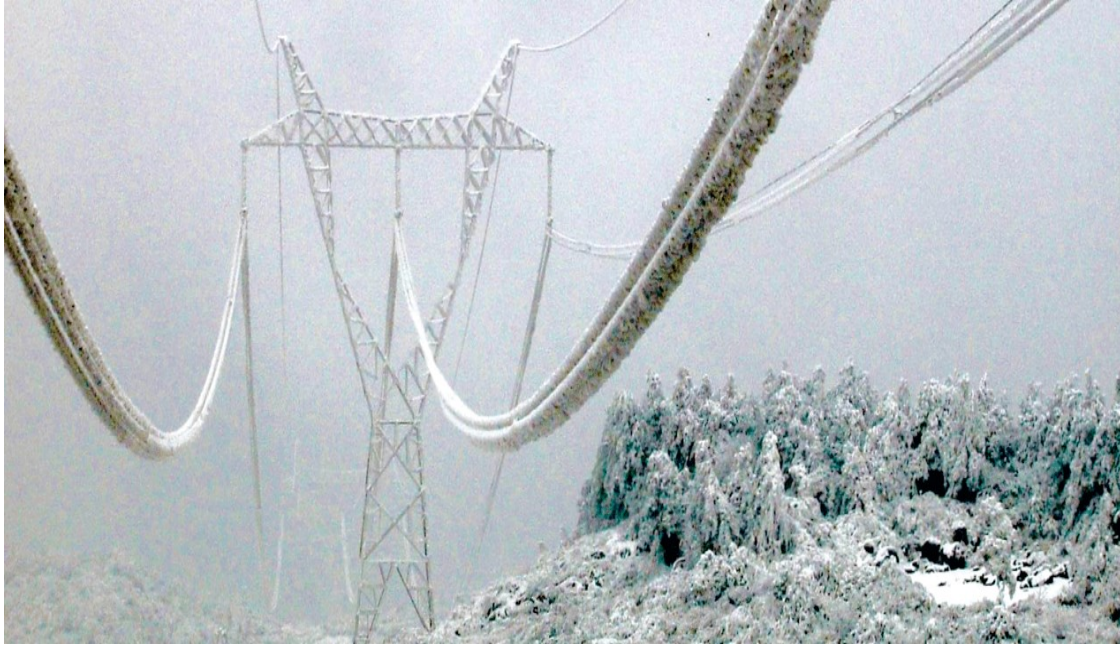
Figure 1.1 Accumulation du verglas sur les lignes de transmission électriques(Enriching Technical Knowledge of T&D Professionals, 2024)
