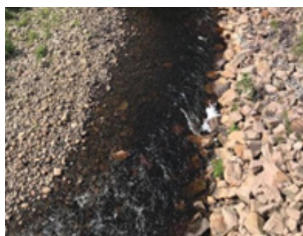
Une rivière naturelle en rive gauche et enrochée en rive droite
