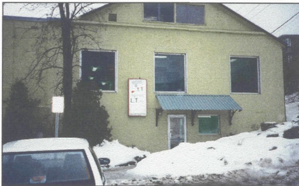
Nouvelle façade extérieure.
