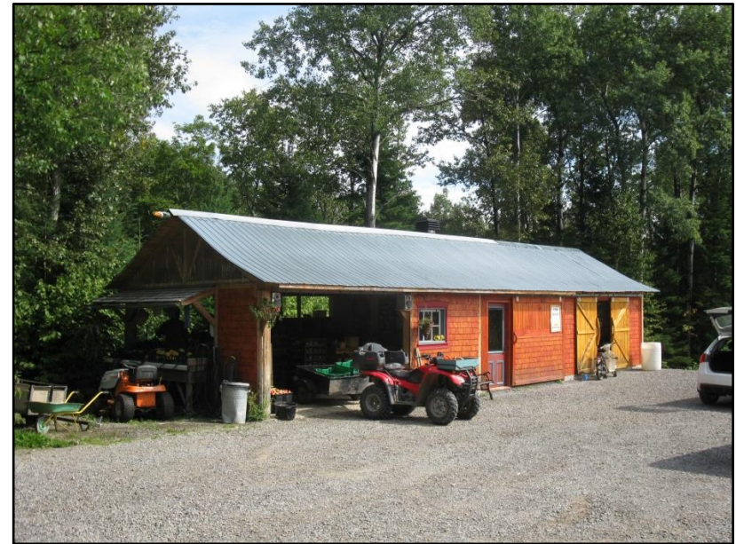
Photo 13 : Bâtiments de ferme horticole (MJG)
