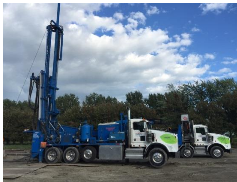
Figure 3-3 : Camion de forage de la compagnie de forage Géopros Lapointe.
