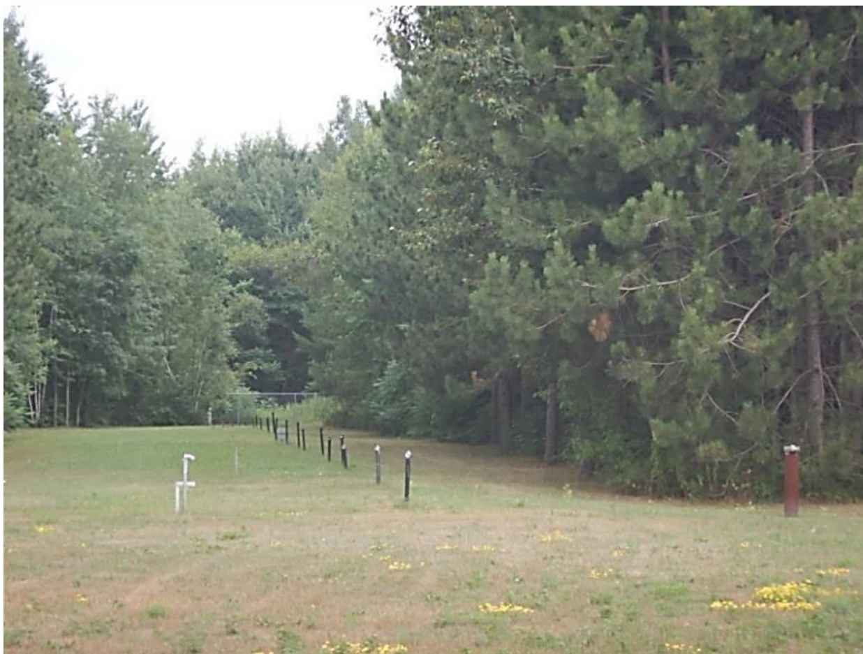
Figure 8-4 : Site de prélèvement d'eau souterraine de la municipalité de Lanoraie constitué de plusieurs pointes filtrantes.
