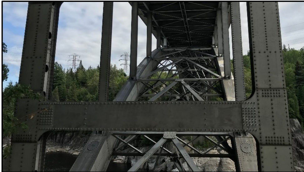
Figure 2-2 – Rivet d’assemblage du pont d’aluminium d’Arvida (© Ève Bilodeau, 2019)
