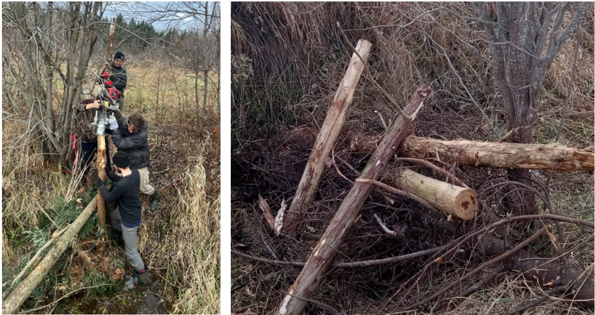
Figure 29. Photographies d'un exemple de projet de restauration low-tech basé sur l'ajout de bois (©Firme Rivières)
